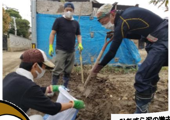
ひたすら泥の撤去 作業を行いました
